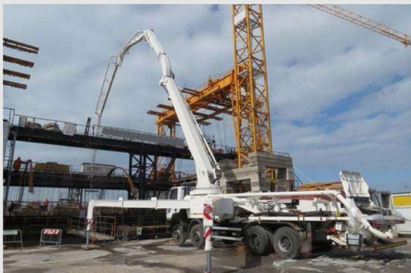
Fig. 3: esempio fase di getto con betoniera ed autopompa
